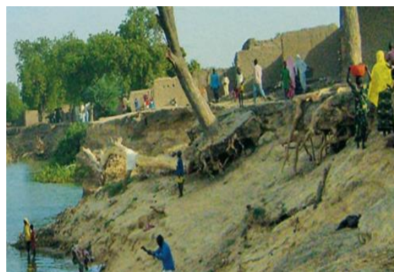
Photo 2 : Destruction des infrastructures par l'érosion hydrique (Source Association Racine)
